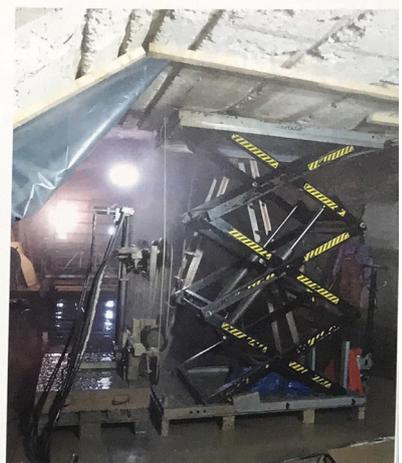
Trennen des Stahlbetons mit Diamantseilsäge
